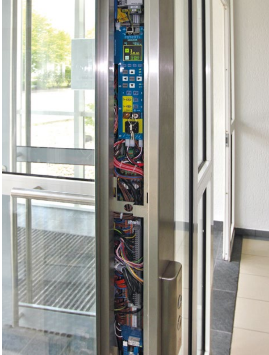
Beispiel einer Aufzugsteuerung in der Schließzarge einer Schachttür Example of a lift control in the lock frame of a landing door
