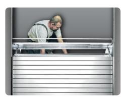
Ein Rolltor, ausgelegt als vollflächige Fahrkorbabschlusstür sichert den Abschluss der Aufzugkabine gegen die Schachtwand.
